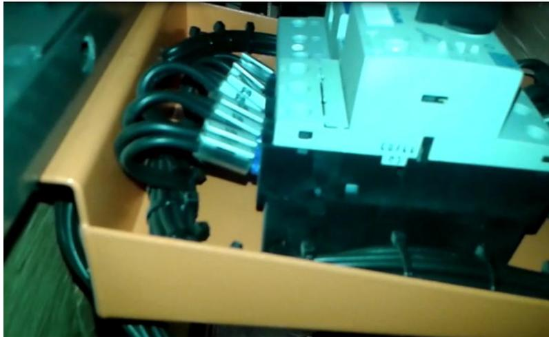
(Figura 8 – Falta tampa de Proteção)
