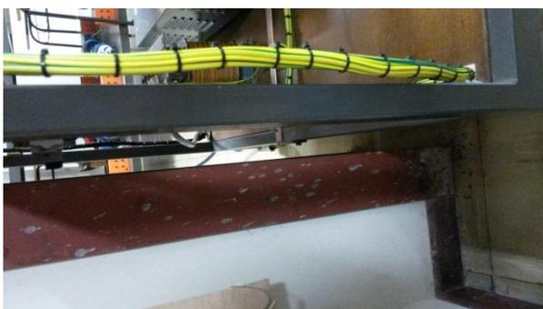
(Figura 13 – Fiação não segue padrões de cores definidos na NBR5410)
