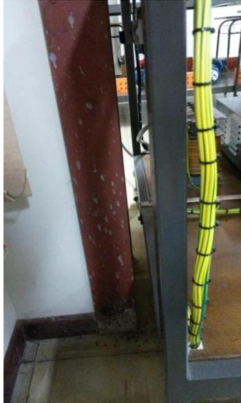
(Figura 15 – Falta de interligação dos circuitos com o BEP)
