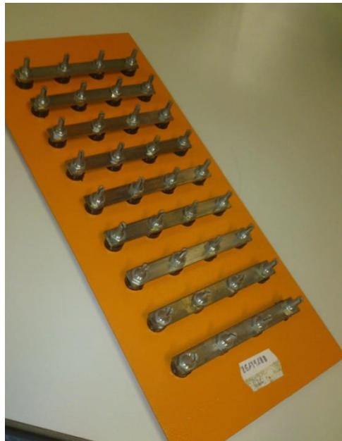
**Irregularidade: Contatos traseiros nas placas de fácil acesso e sem proteção (risco de choque)**
