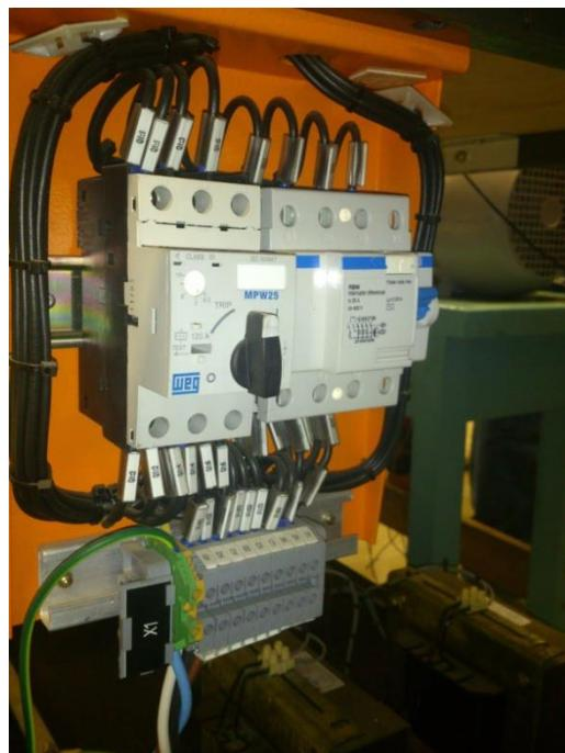
**Irregularidade: Bancadas possuem disjuntor DR, mas não possui aterramento e não está interligado à malha de terra**
