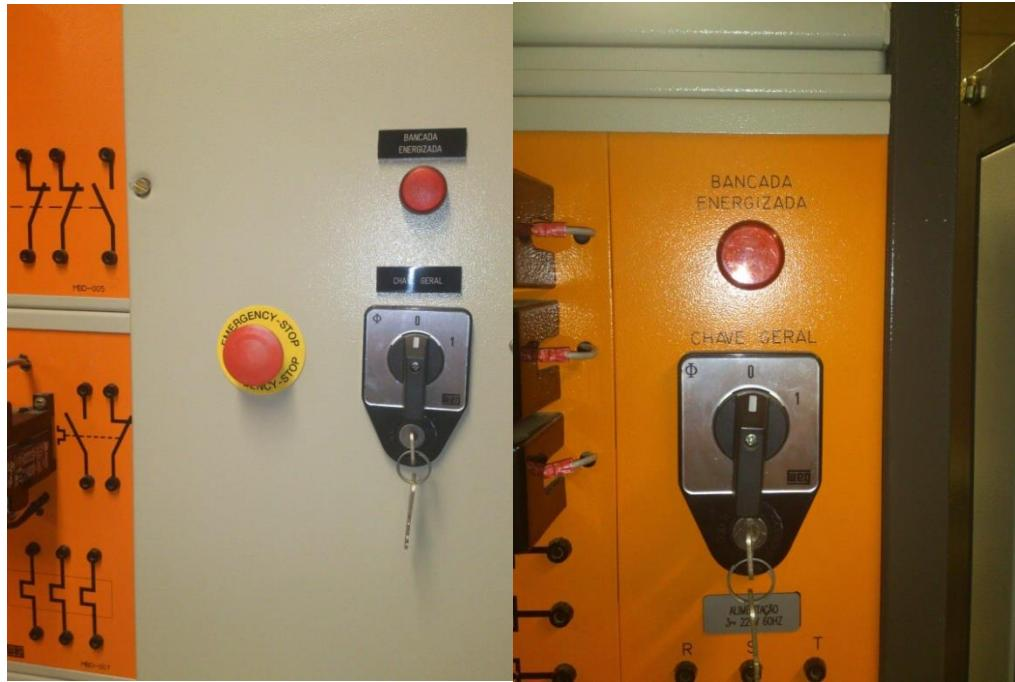
**Irregularidade: Ausência de botão de emergência nas bancadas / botão de emergência com mau funcionamento ou inoperante**
