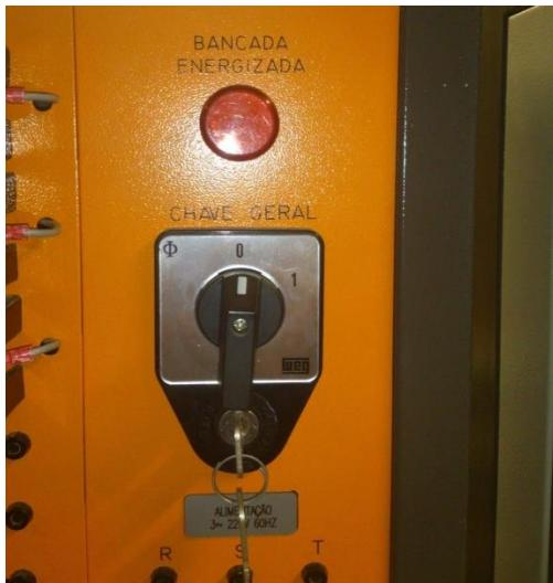
**Irregularidade:Não utilização do dispositivo de bloqueio de chave de segurança durante os procedimentos realizados nas bancadas**
