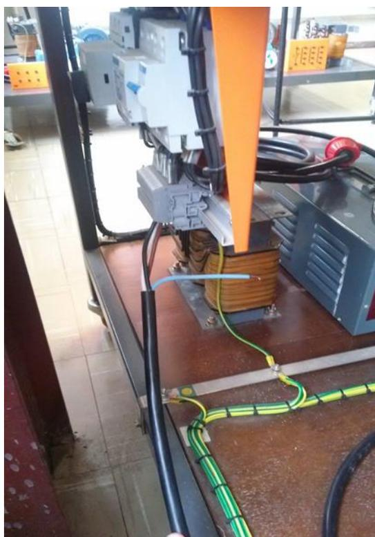
Figura 8 – Malha de terra desconectada.
