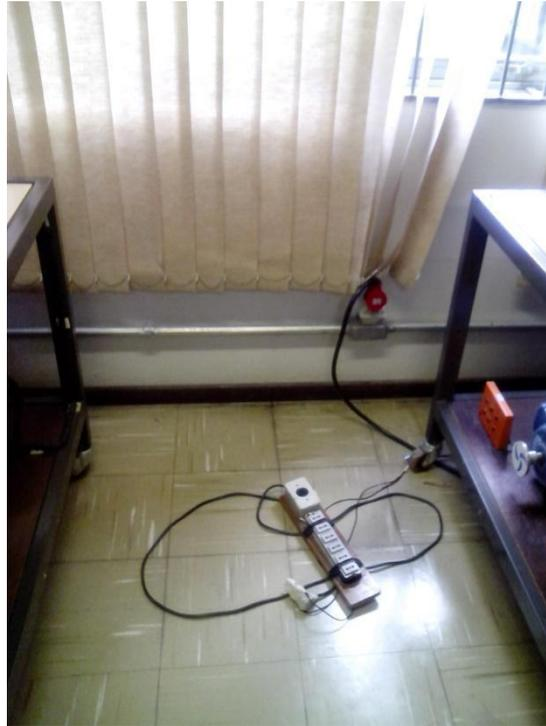
Figura 9 – Instalações mal instaladas e improvisadas.
