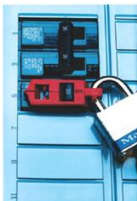
Figura 1 – Lock-out . Fonte: Brady Corp (2014)
