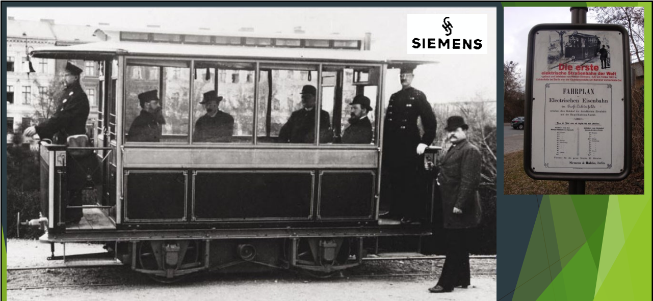
Lichterfelde (Berlin) tram, 1882 2,4 km, 180 Volt DC, Motor 4 kW (5,4 hp)
