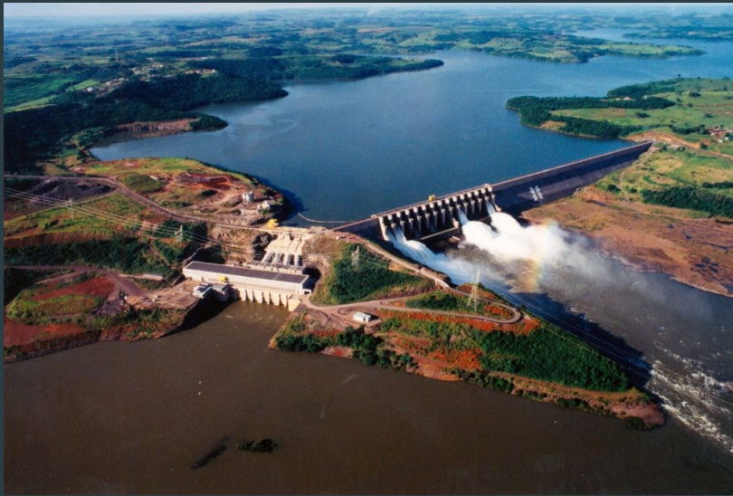
Usina Hidrelétrica Governador José Richa
