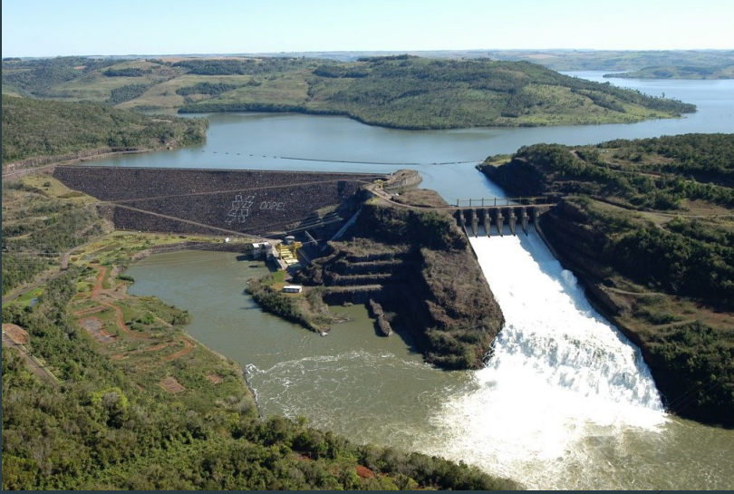
Usina Hidrelétrica Governador Ney Amintahas de Barros Braga
