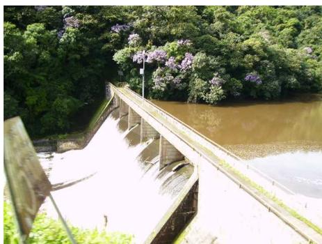
**Reservatório da Usina Marumbi na Serra do Mar (Morretes), que represa o rio Ipiranga. Localiza-se a 3km da usina e a água corre por duas tubulações de aço até a casa de força, com desnível de quase 500m.**
