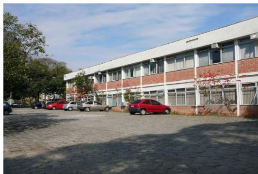
Figure 1 - Bâtiment du département d'ingénierie électrique
