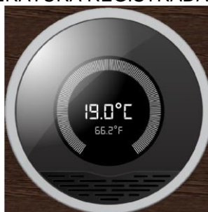
FIGURA 20 - TEMPERATURA REGISTRADA NO SUPERVISÓRIO
