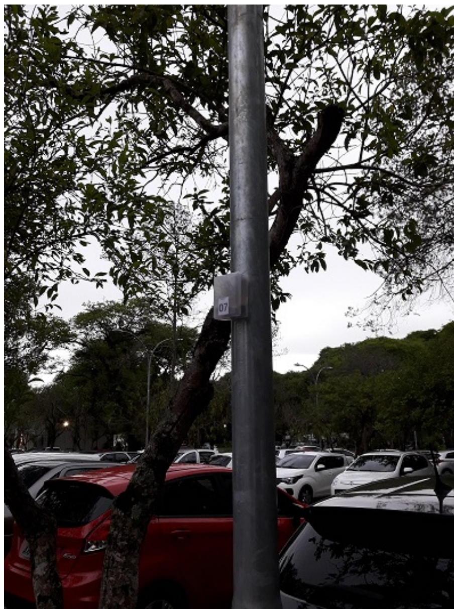
Figura 37 – A instalação do sistema eletrônico no poste.
