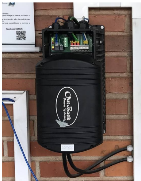
Figura 15 – Inversor Outback conectado ao sistema do Laboratório
