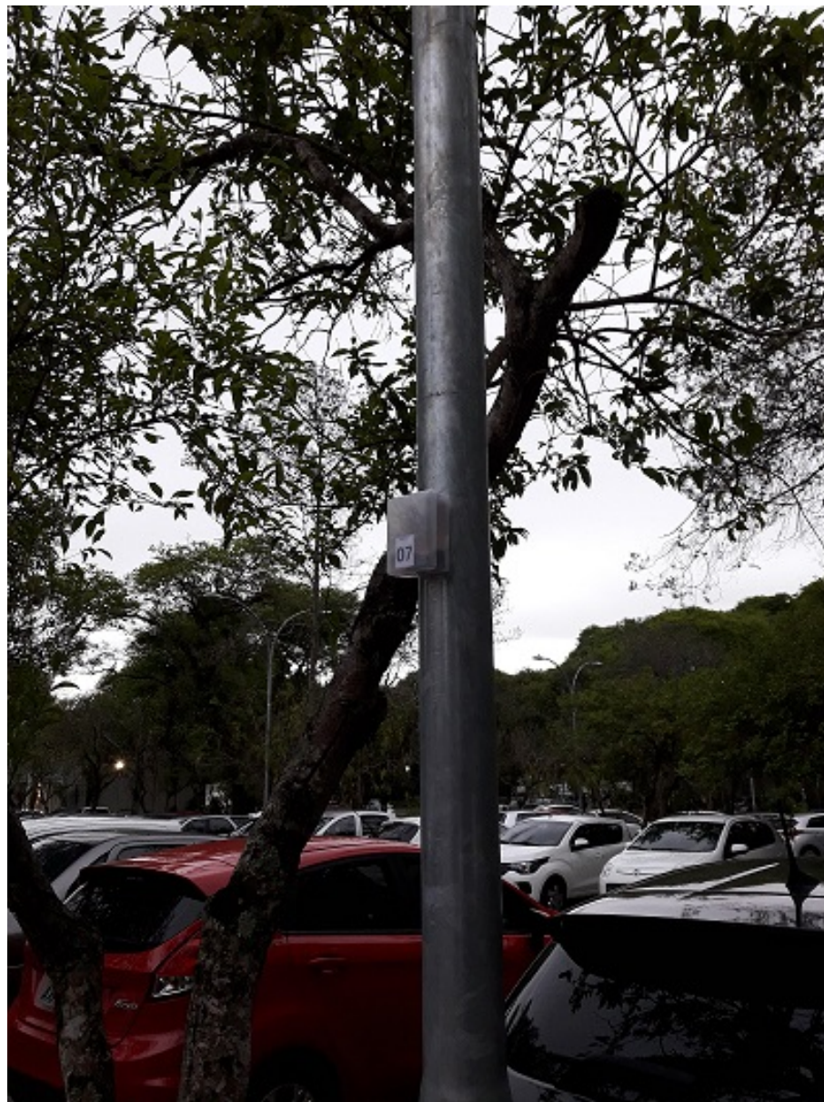
Figura 37 – A instalação do sistema eletrônico no poste.
