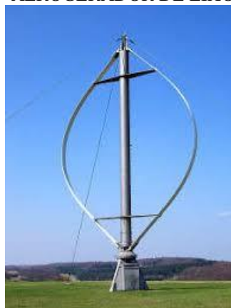
FIGURA 5 – AEROGERADOR DE EIXO VERTICAL
